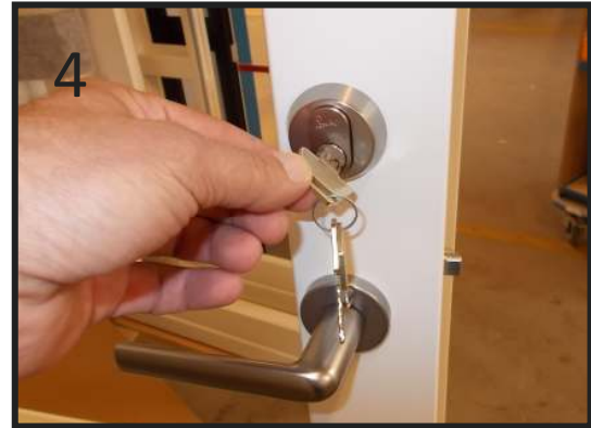
Nu kan døren KUN låses og låses op vha nøgle på såvel udvendig- som indvendig side
